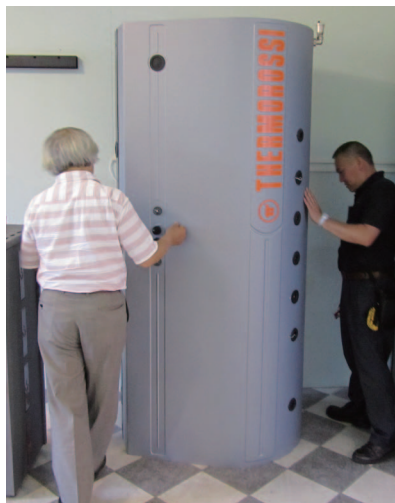
今回設置したものと同型の500 リットル 蓄熱層「thermocell500」
