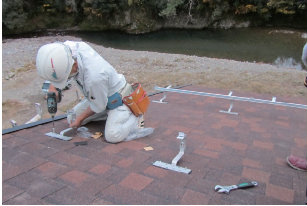
屋根に太陽集熱器のブラケットを取付け作業中の様子
