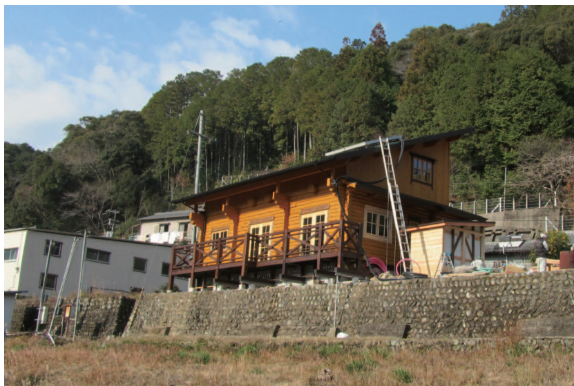
南向き斜面地に建つY邸の遠景。右がボイラーなどを設置した小屋
