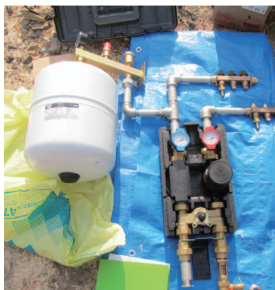
左から床暖房回路の循環ポンプキット、小屋内の配管や器具の接続状況、密閉回路に不凍液を注入する移動式ポンプ
